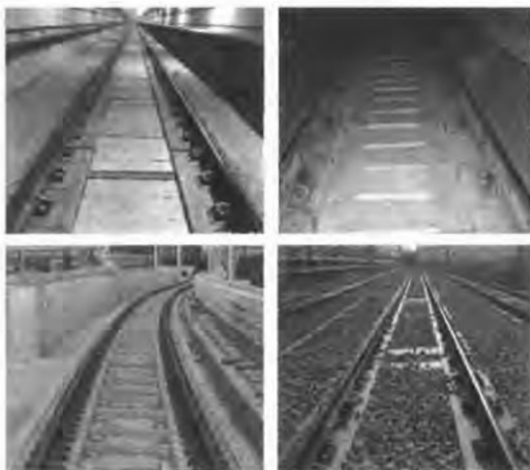
图4 国内各地城市轨道交通中铺设的梯形轨枕
