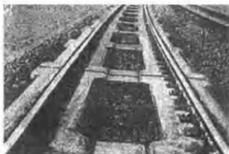
图 1 梯形轨枕的雏形——最早的纵向连续轨枕
