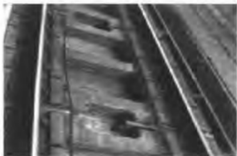
图 2 梯形轨枕的前身——设有混凝土横梁的纵向轨枕
