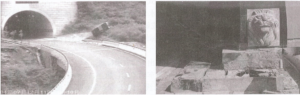
图 5-2 端墙式隧道洞口交通事故示例
