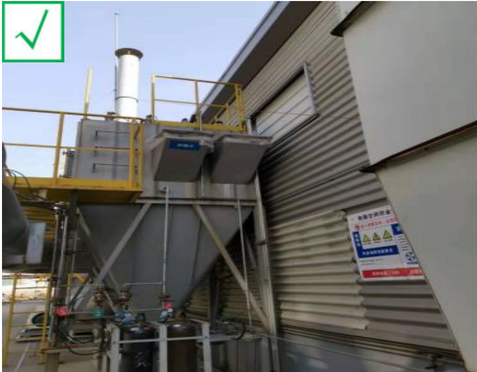
情景描述：铝镁制品机械加工除尘系统使用惰性气体作为灭火介质。
