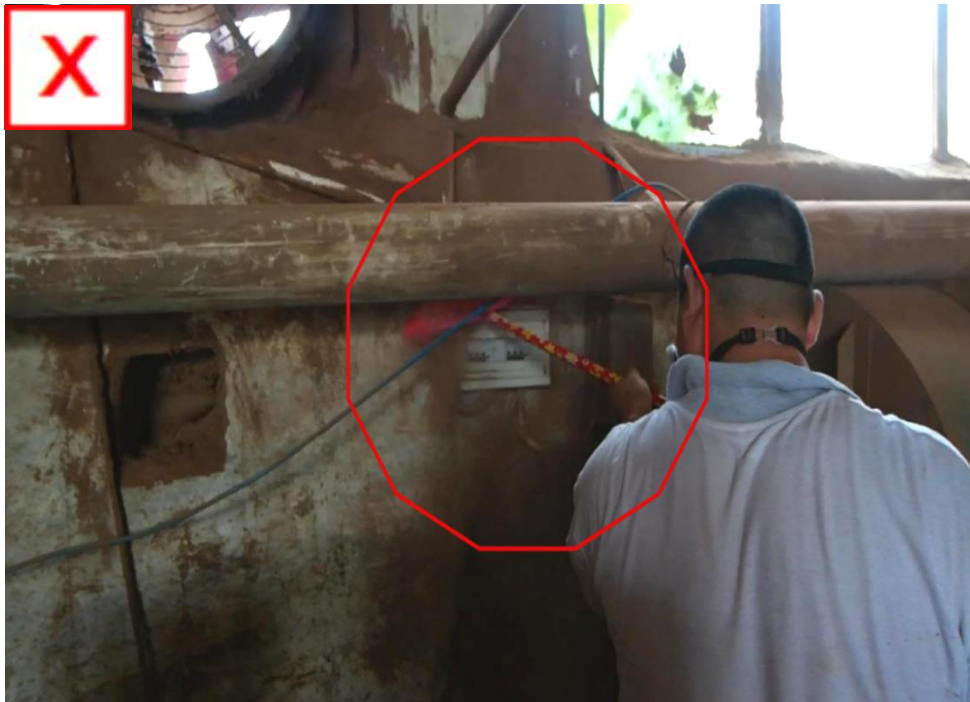
隐患描述:电源箱附近积尘, 清扫作业未切断电源。
