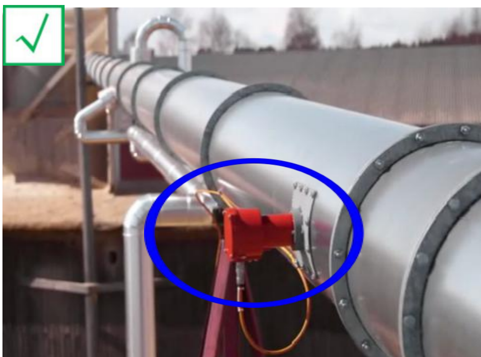
隐患描述；木质板材砂光的砂光机连接的主风管上设置火花探测和熄灭装置。
