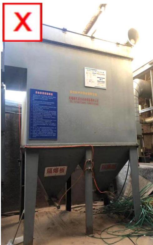
重大隐患描述：木粉尘除尘系统无任何控爆措施。
