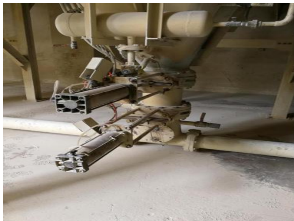
情景描述：锁气卸灰装置-双层气动双闸板阀。
