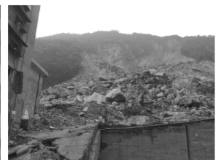
图5 北川中学被山体 崩塌完全掩埋
