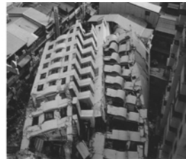
图 1 平面特别不规则建筑因扭转破坏而倒塌
