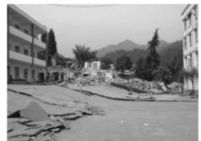
图7 地表挤压陡坎上 的房屋倒塌
