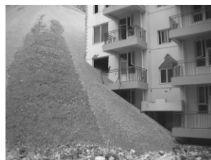
图4 新建住宅楼被山体 滑坡部分掩埋
