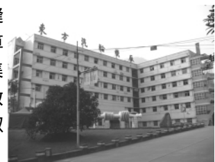
图7 L形平面建筑 不设缝的震害较轻
