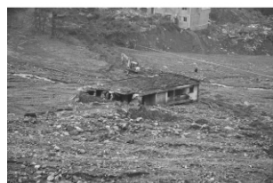
图6 泥石流将住宅楼 大部分掩埋
